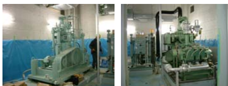
空気圧縮機 空気排気装置(真空ポンプ)
